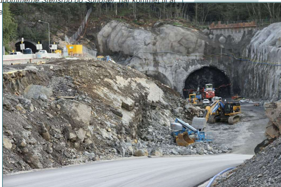
Byggingen av E39 Eiganestunnelen startet i 2014 og kontrakten hadde en verdi på rett over to milliarder kroner. Tvisten om sluttoppgjøret i prosjektet har vært gjennom to rettsinstanser. Nå er saken anket til Høyesterett.
